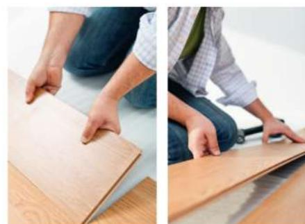
новых и прочих веществ для нанесения на замковые соединения. Недопустимо попадание посторонних частиц в замковое соединение.
